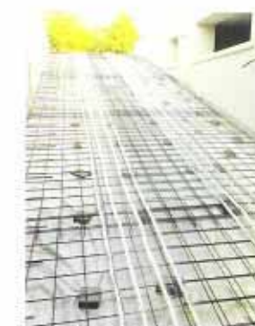
Colocación de redes en rampa de garaje
