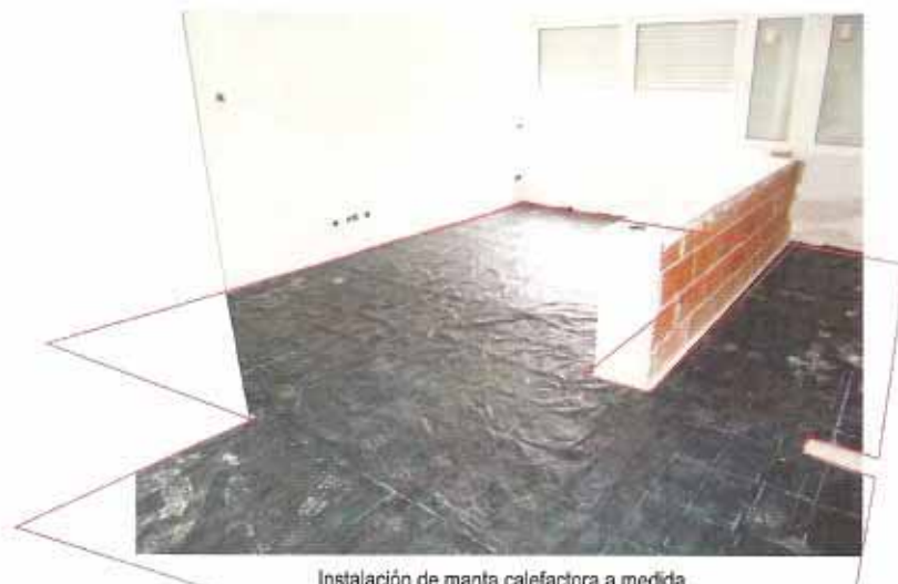
Instalación de manta calefactora a medida
